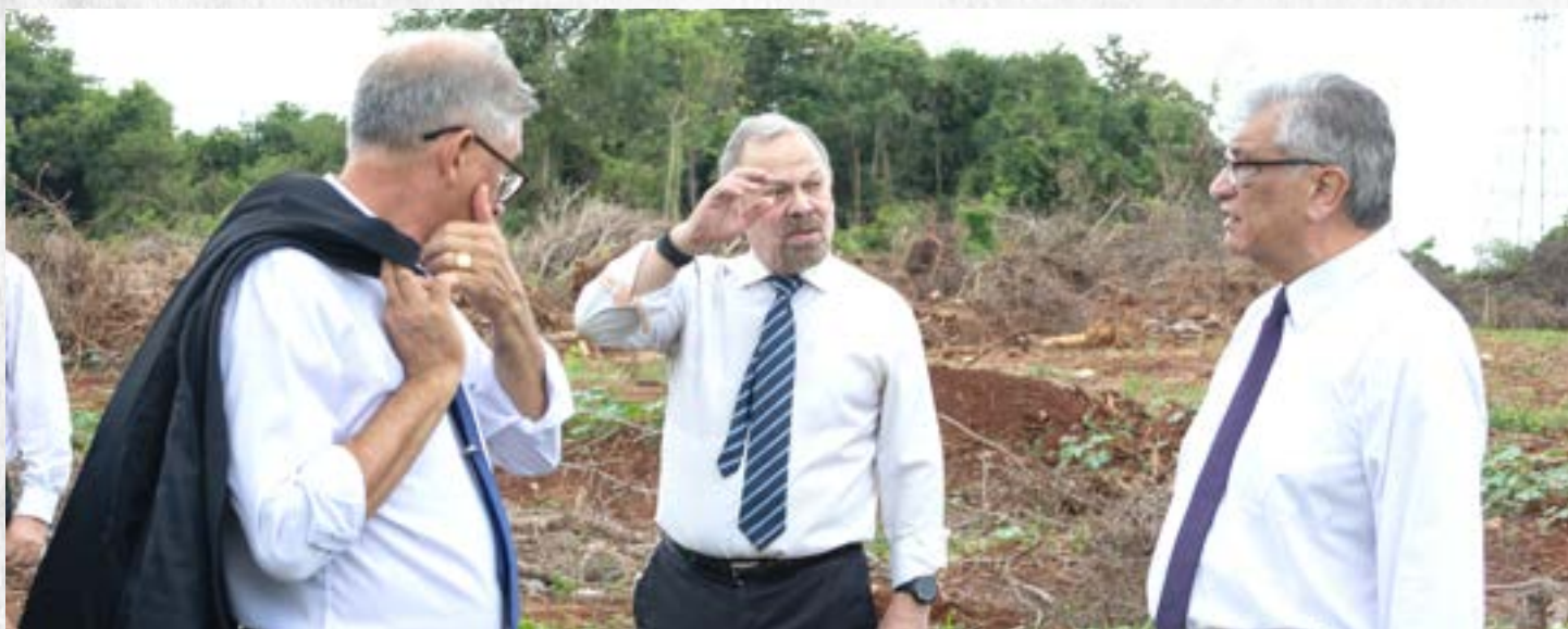
Trabajos iniciales para la construcción de la Pista de Atletismo de la UNE.
