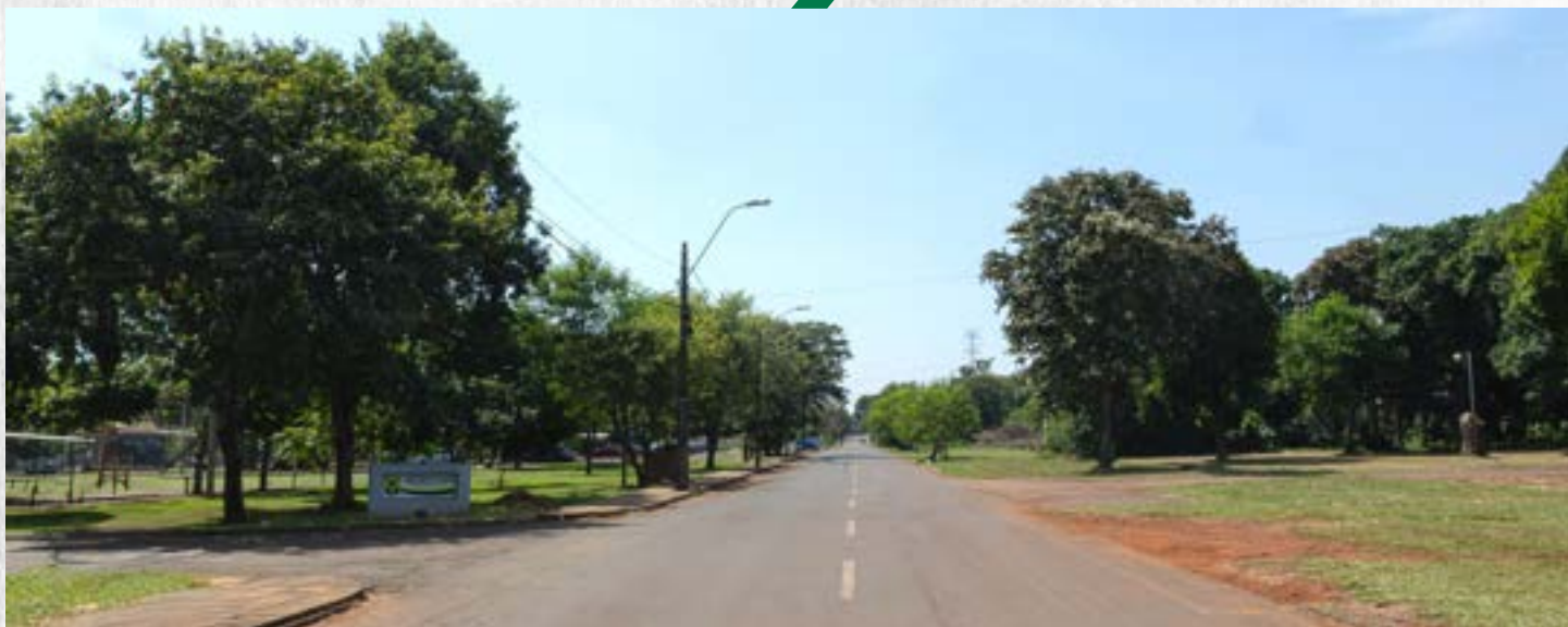
Recapado de la avenida principal del Campus Universitario de la UNE.
