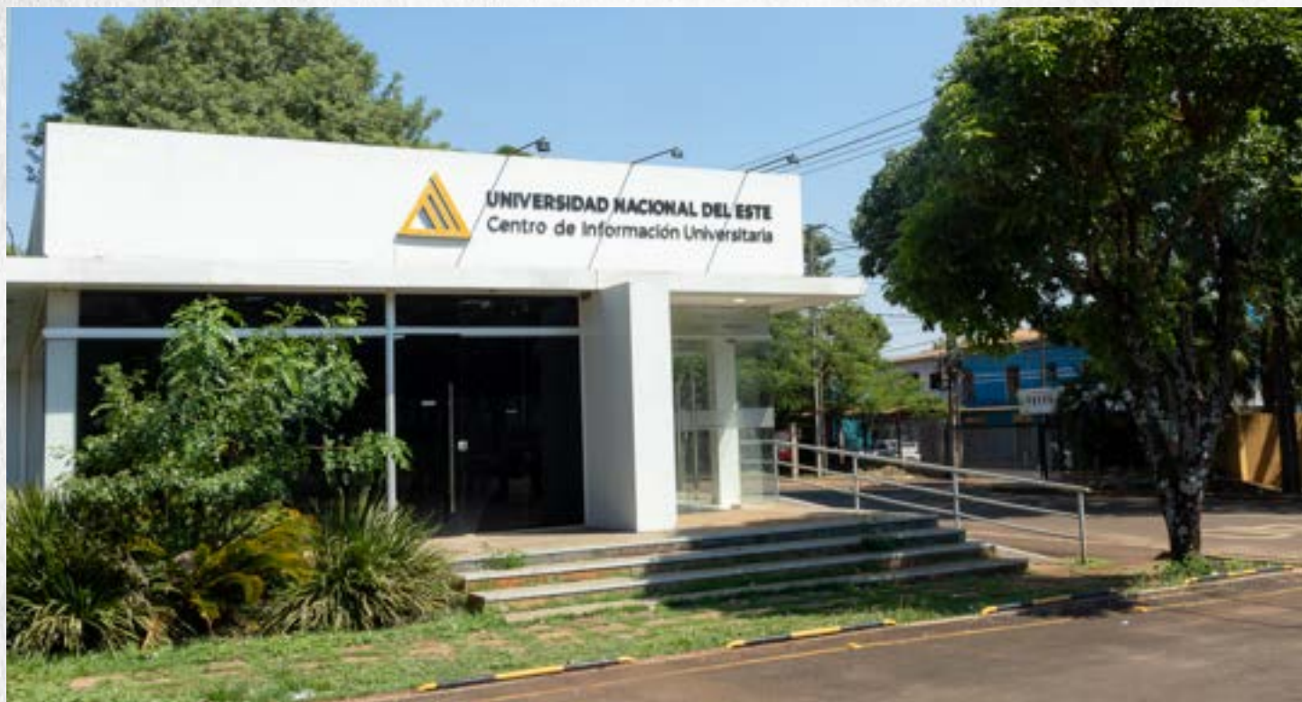
Adecuación del espacio edilicio para el Centro de Información Universitaria (CIU).
